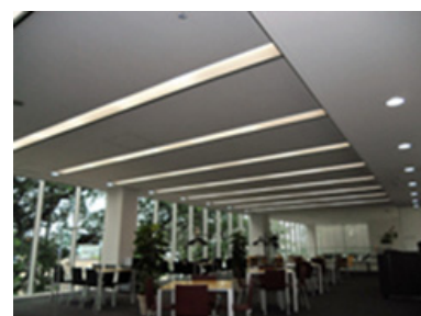
八王子技術センターロビーのLED照明
